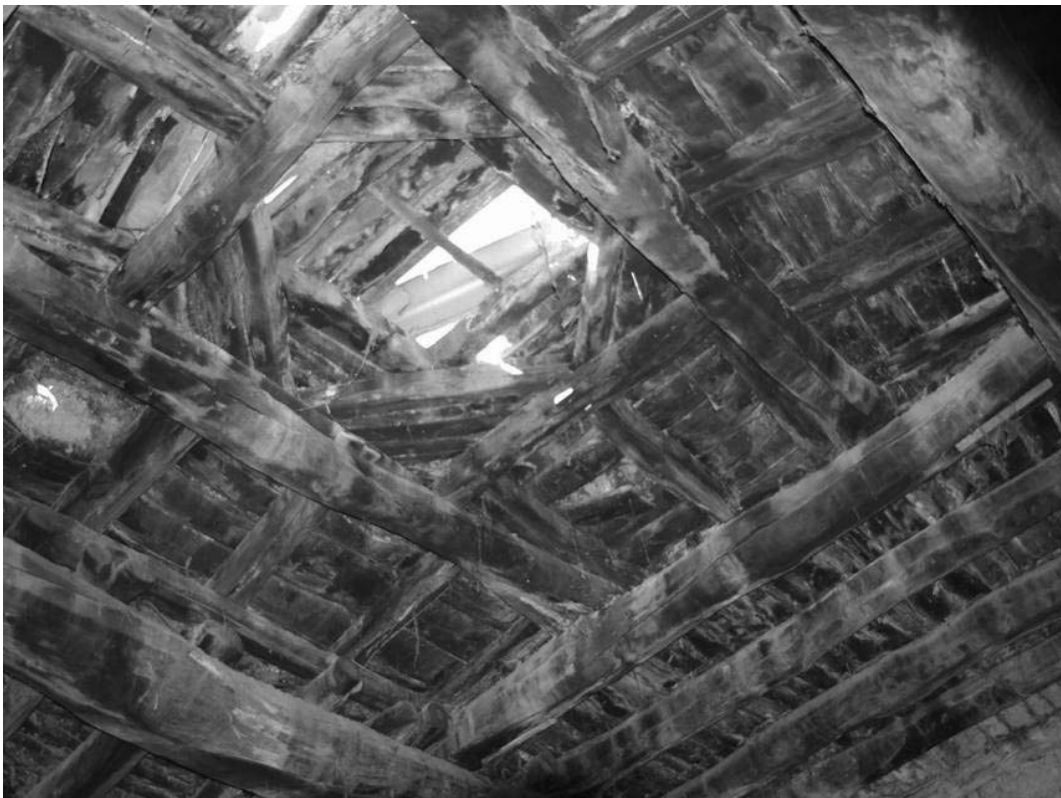
Maison avec toit à lanterne – Village d'Areni
