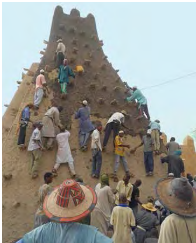
Mosquée Sankoré, crépissage du minaret, juin 2013 (photo ALDI)
