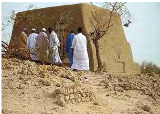
Mausolée Alpha Moya avant démolition (photo Sane Chirfi Cisse, juillet 2005)
