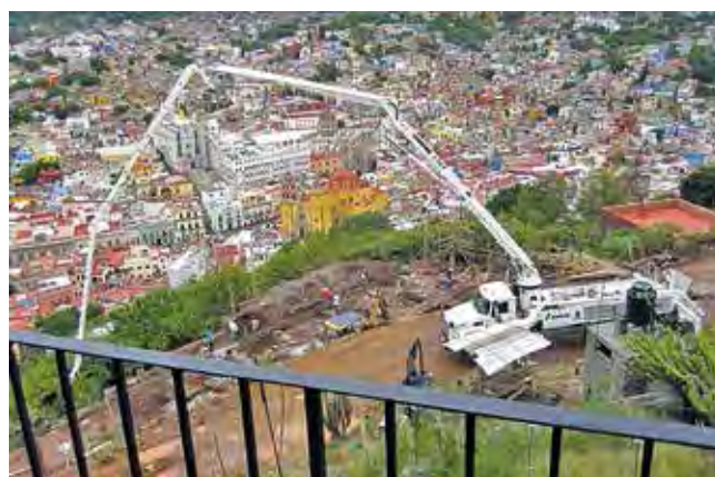
Vista de las obras de ampliación del Hotel Misión Casa Colorada en Guanajuato
