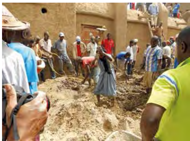
Mosquée Sankoré, préparation du mortier pour l'enduit (photo ALDI)
