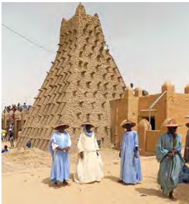
Crépissage de la Mosquée Sankoré, vieux maçons traditionnels, juin 2013 (photo ALDI)
